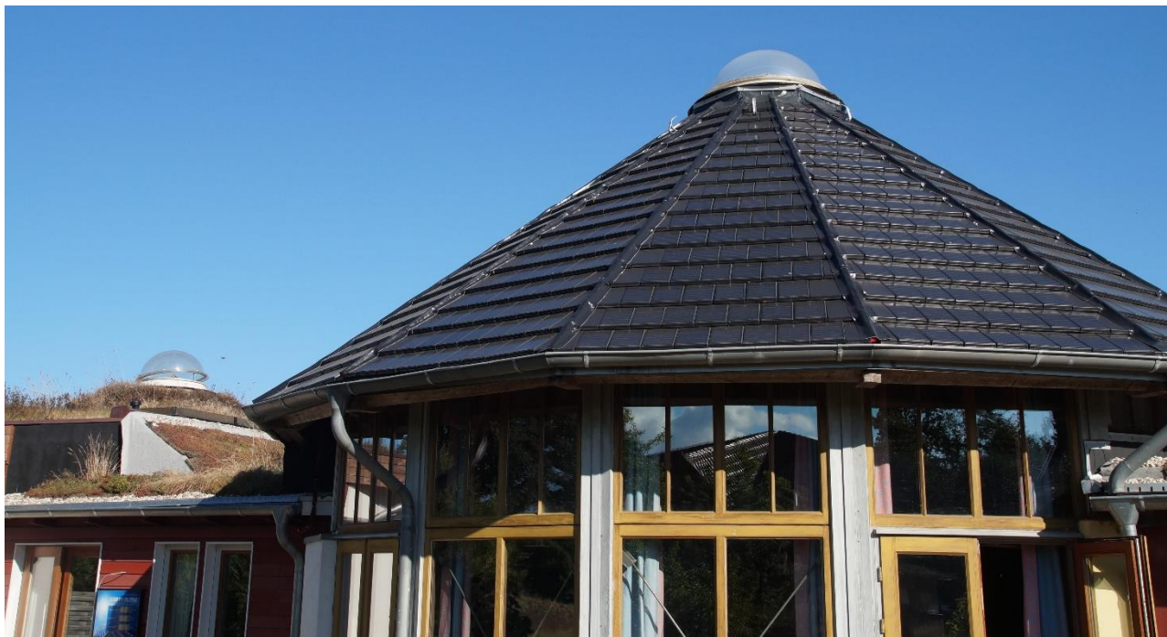
Abbildung 6.6-2: Dachsanierung mit integrierten Solarziegeln
