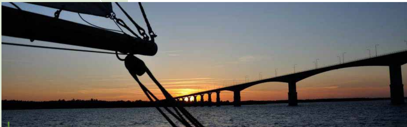
Die Ihana und die Ölandbrücke in Schweden.
